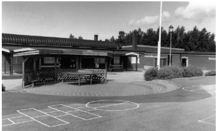
Kronoparksskolan efter tillkomsten av ventilationschakt på tak och fasadändring, förmodligen sent 1990-tal. Foto: Erik Follin
