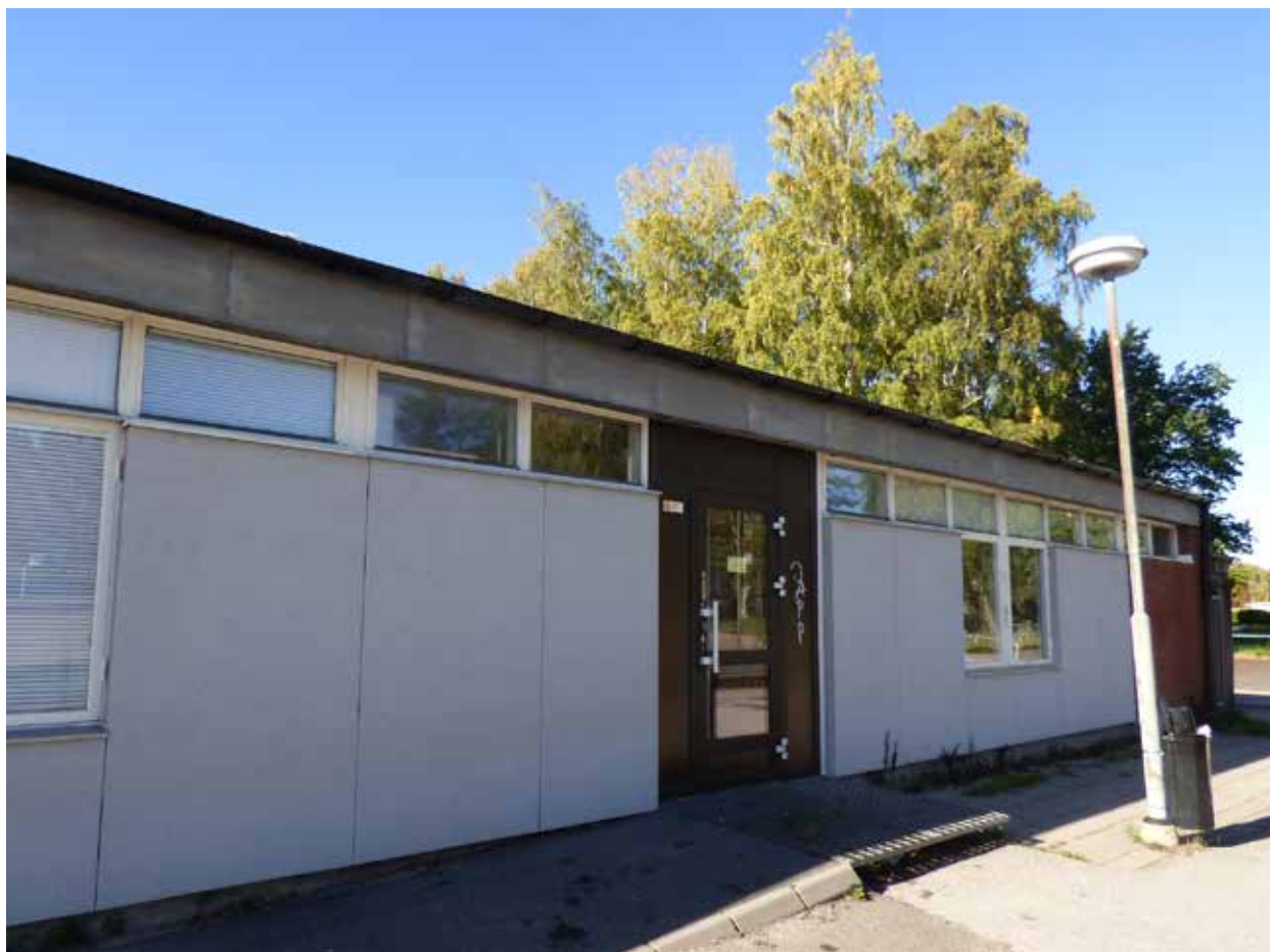
Exempel på fasad som ersatts med skivor i krossad sten och dörr i lättmetall, i övrigt ursprunglig utformning, notera den tidstypiska fönstersättningen och den markerade takomfattningen i plåt.
