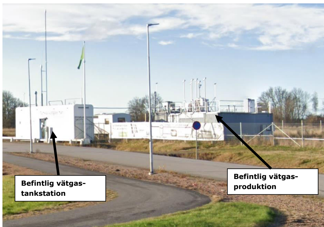
Figur 5-2 Befintlig vätgasproduktion och tankstation.
