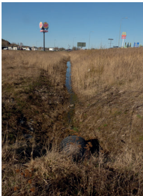
Anlagt dike längs med Göteborgsvägens västra sida .
