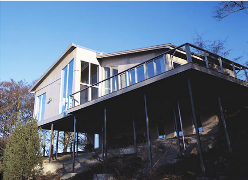
Hus på pelare med indragen sutterängvåning. Luftrum, arkitekt Mats Sjökvist, Hus1.
