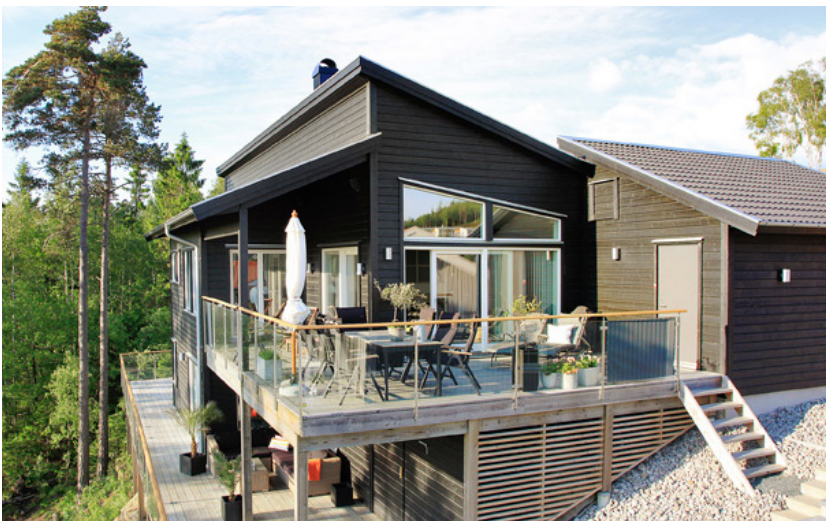
Hus med suterrängvåning och pelare. Villa Kattvik, A-Hus.
