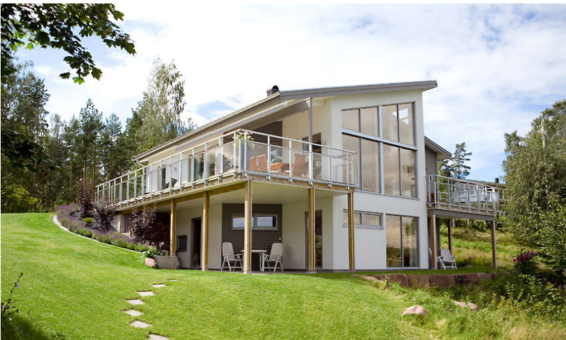
Sutteränghus. Förtöjning, arkitekt Mats Sjökvist, Hus1.
