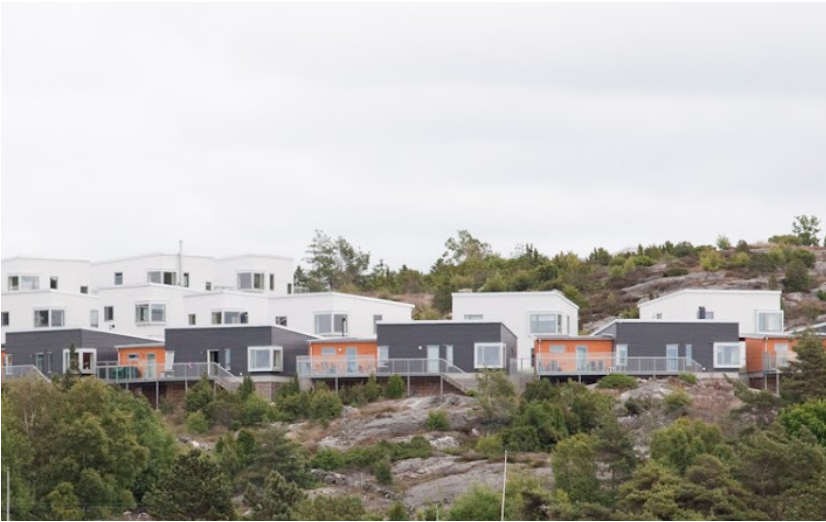
Husen på Käkenäsvägen i Stenungsund är inpassade i terrängen med utsikt över havet.
