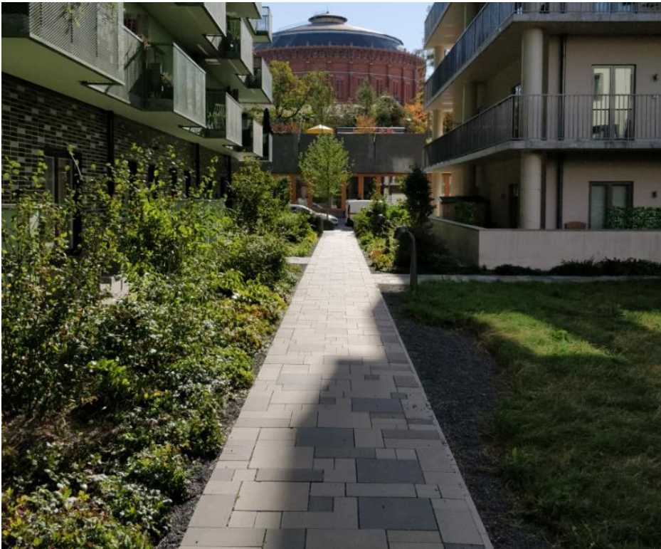
Figur 7-5 Inlopp med bred front till växtbäddar.
