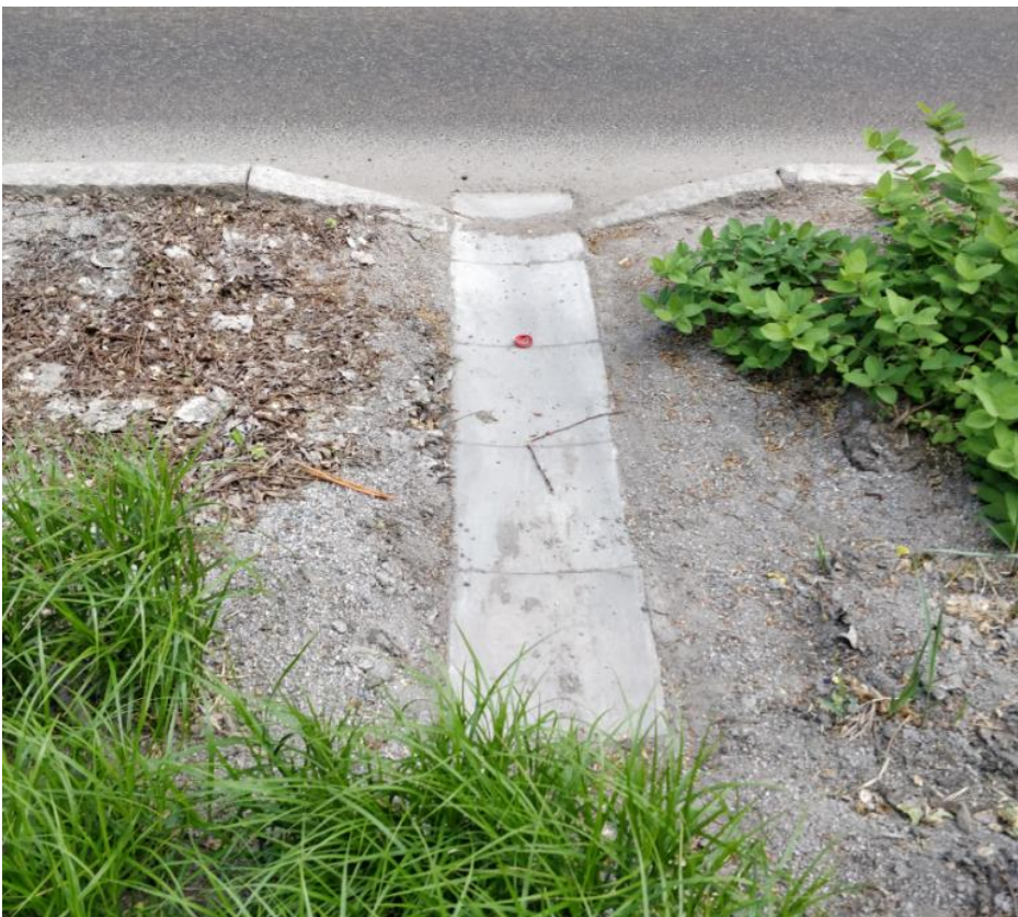
Figur 7-6 Koncentrerat inlopp till växtbäddar.
