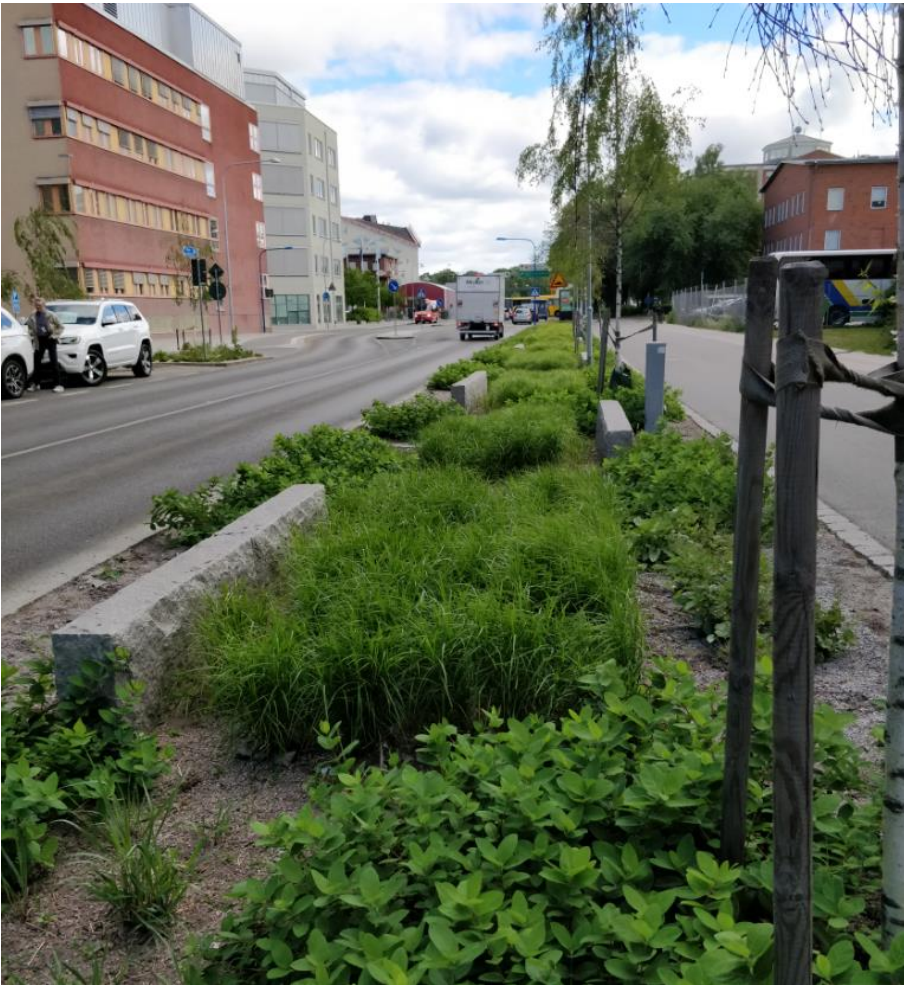
Figur 7-3 Exempel på nedsänkt växtbädd längs med väg.
