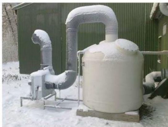
Figur 4-1. Enklare kolfilter från Evodor.
