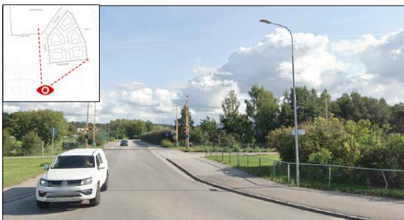
Vy 2 - Vy från Strandvägen. Befintlig situation.
