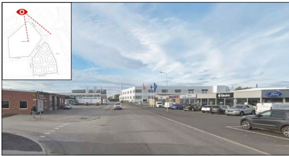
Vy 1 - Vy från Strandvägen. Befintlig situation.
