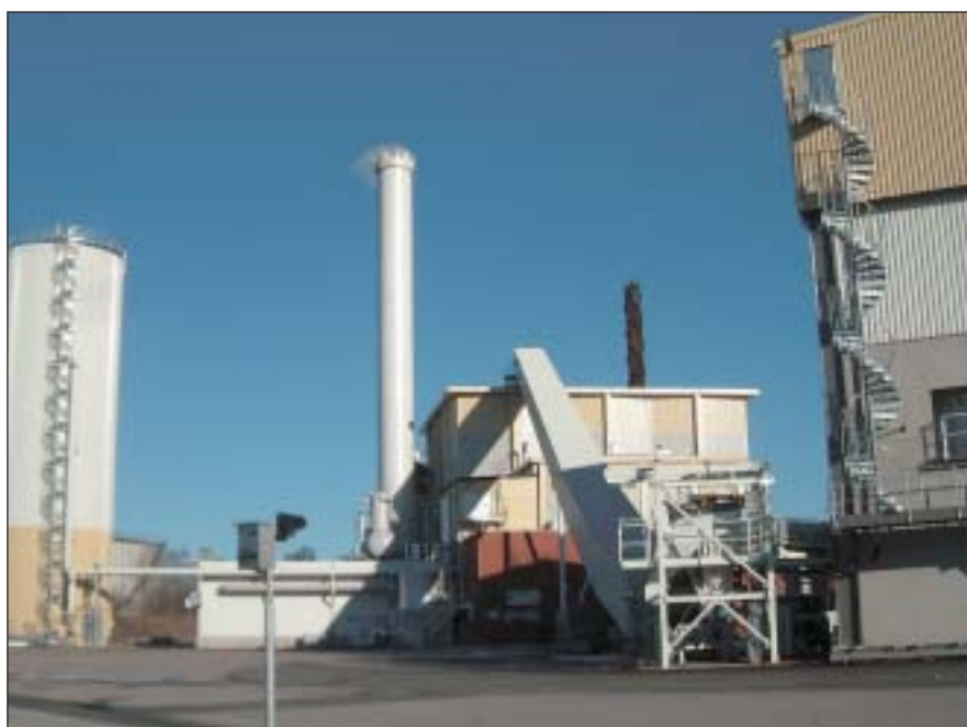
Nytt kraftvärmeverk producerar värme för fjärrvärmenätet och elektricitet.
