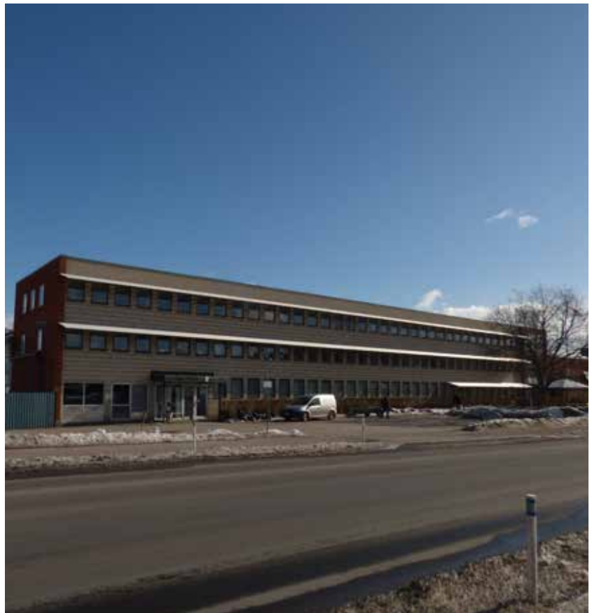
DS Smith (tidigare SCA) wellpappindustri med tillhörande kontorsbyggnad öster om planområdet.
