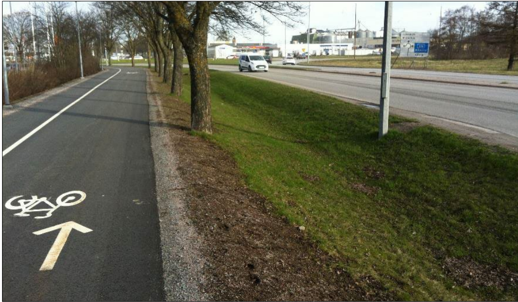
Figur 7. Exempel på svackdike (dock mycket större än i föreliggande förslag) för omhändertagande av dagvatten från väg och gc-väg (källa WRS 2024).
