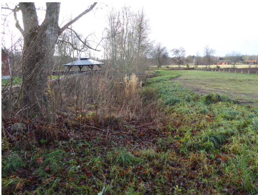
Figur 19. Åkerdike för bortledning av renat avloppsvatten.
