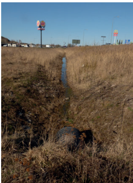
Anlagt dike längs med Göteborgsvägens västra sida
