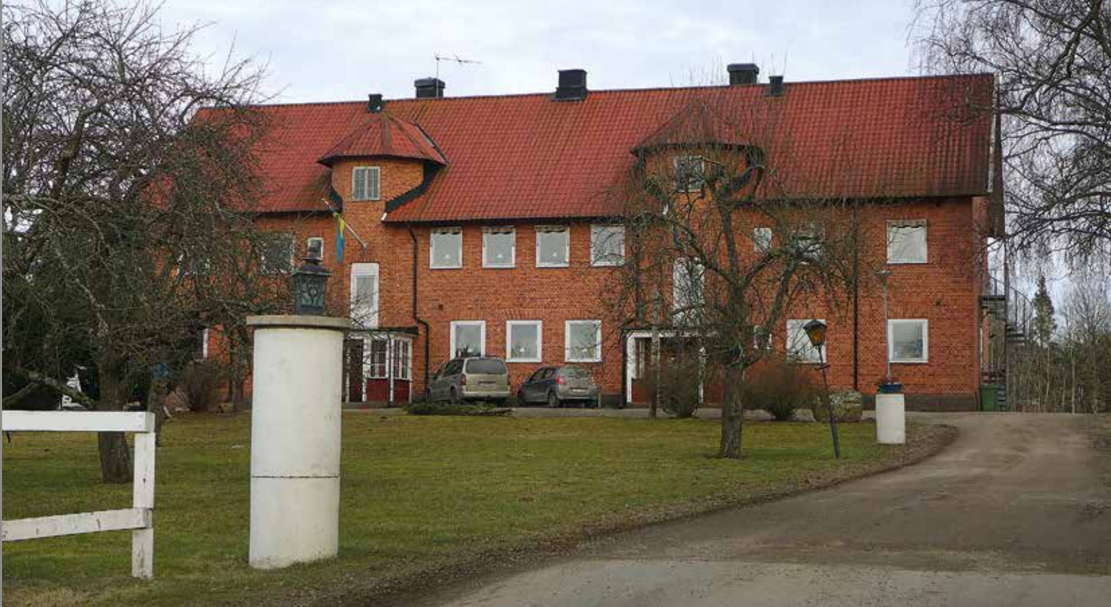
Figur 30. Vallby före detta ålderdomshem från 1914 är trots vissa senare förändringar ett gott prov på tidig institutionsarkitektur i tegel och ett viktigt kulturarv från 1900-talets framväxande välfärdssamhälle.
