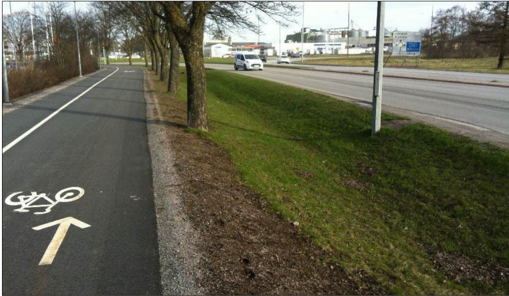
Figur 7. Exempel på svackdike (dock mycket större än i föreliggande föreslag) för omhändertagande av dagvatten från väg och gc-väg (källa Smith m.fl. 2022).
