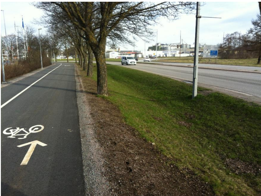
Figur 26. Exempel på svackdike (dock mycket större än föreslaget här) för omhändertagande av dagvatten från väg och gc-väg.
