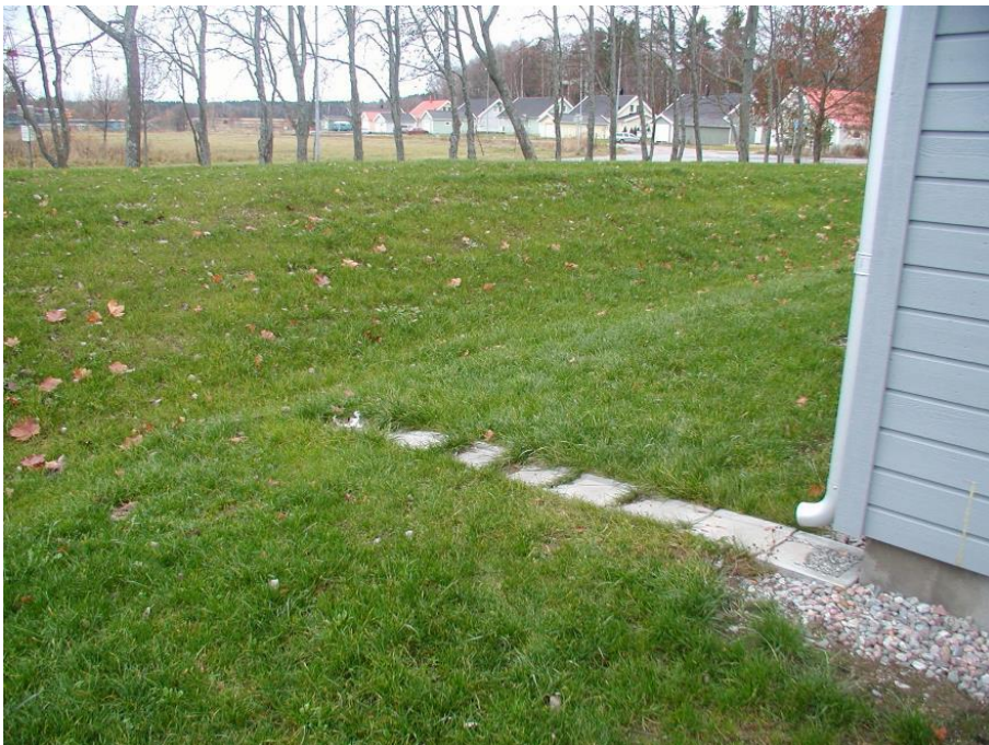
Figur 25. Exempel på stuprör med utkastare till ränna som leder bort takdagvattnet till ett svackdike där vattnet kan infiltrera och även, vid högre flöden, avledas kontrollerat.
