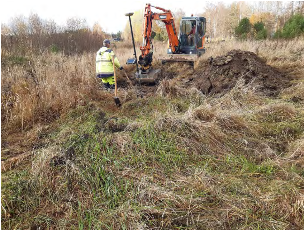
Figur 5. Grävning av schakt strax bakom jordupplag till golfbanan (klubbhus kan anas i bild strax ovan arkeologens huvud).
