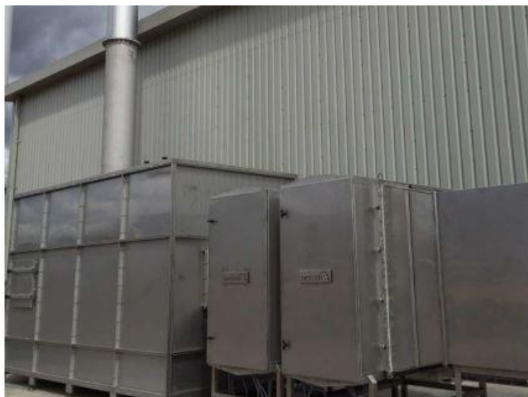
Figur 4-6. Fotooxidation(UV) i kombination med aktiverat kolfilter (Centriair).
