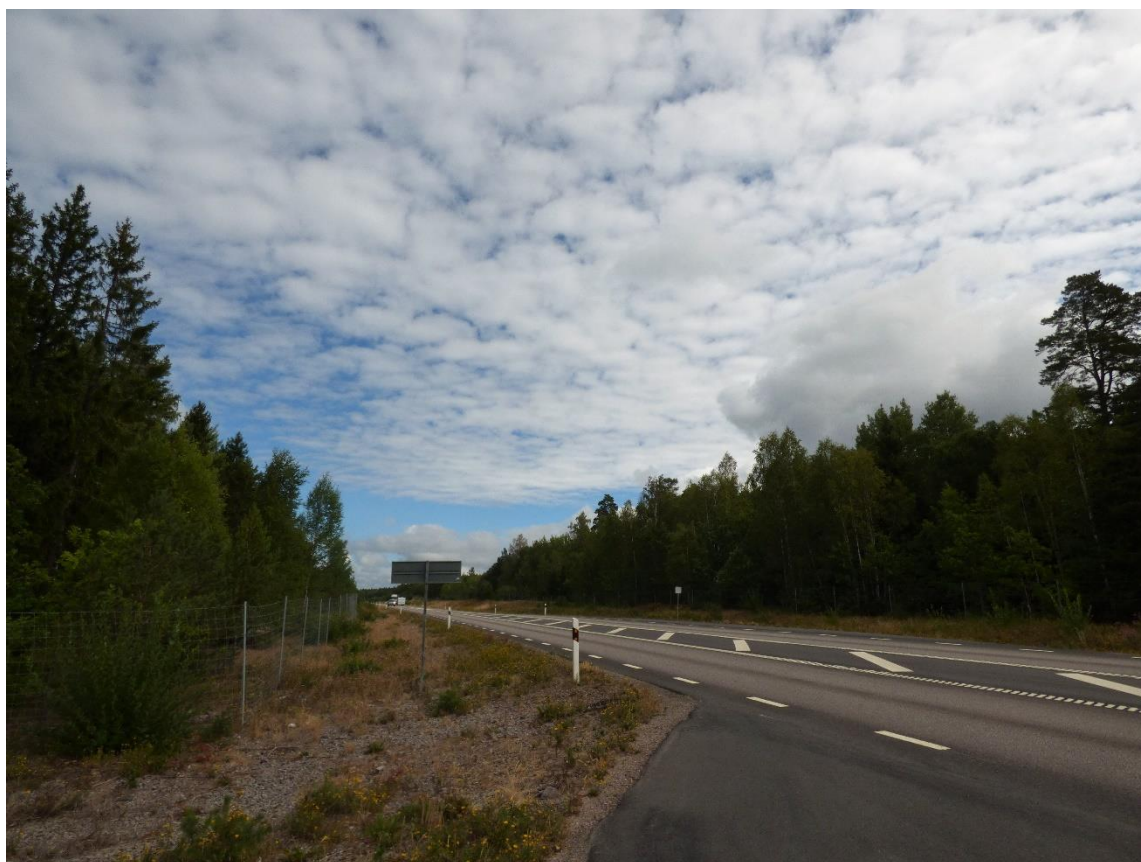
Väg 26 utanför planområdet sett norrut.
